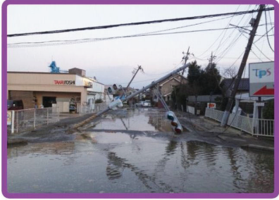
液状化現象が起きます。 [東日本大震災] (東京消防庁提供)
