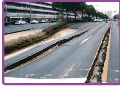
道路が割れます。 [阪神・淡路大震災] (東京消防庁提供)
