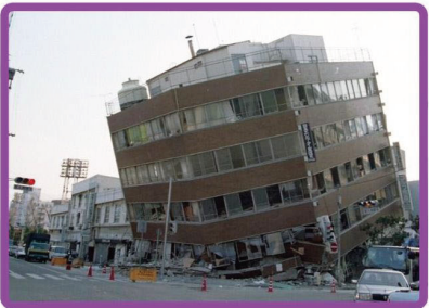
ビルがぐずれます。 [阪神・淡路大震災] (神戸市提供)
